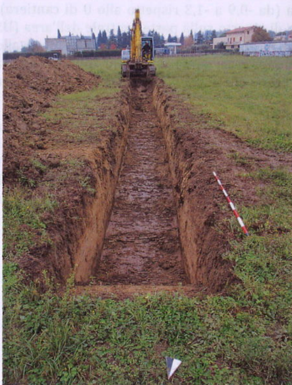
Fig. 1: Trincea 1 in corso di scavo vista da NO
